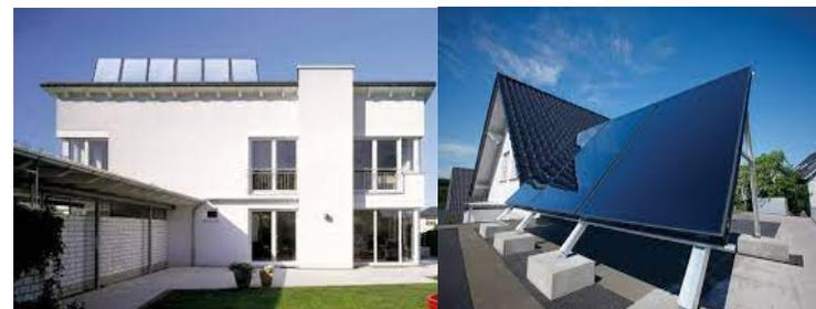
Рисунок 2 – Коллекторы с отражателями на фасадах жилых домов
